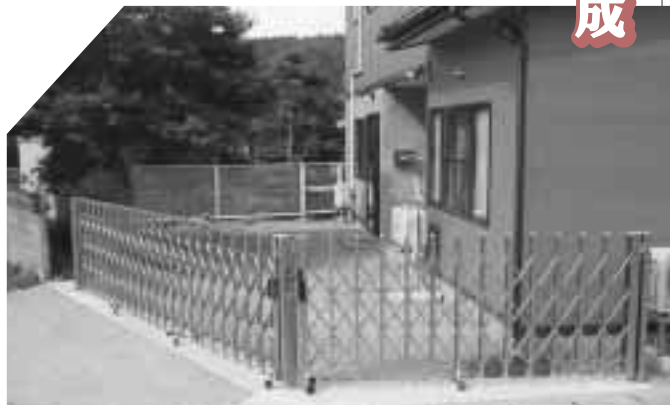
助成により整備した門扉・フェンス
